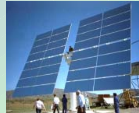
100 m 2 Heliostat (DLR - PSA)
